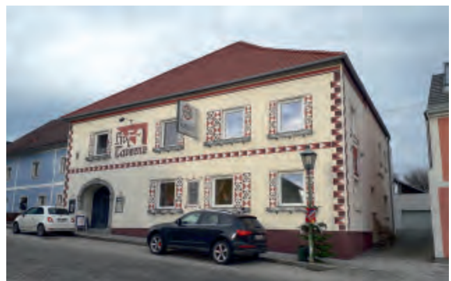
Abb. 18: Marktplatz 12: Zum Haus gehörte ein ungewöhnlich großer Kellerraum, spitzbogig gewölbt und 5 m hoch.
