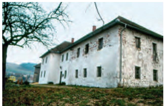
Abb. 8: Erdstall Bauernhofer: Abbildung von 1983 – der Erdstall verlief unter dem rechten Gebäudeteil. Dieser ist jetzt durch einen Neubau ersetzt und der Erdstall nicht mehr zugänglich.
