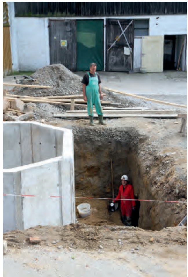
Abb. 42: Gelegentlich kommen bei Grabungsarbeiten Erdställe zum Vorschein. Wichtig ist, dass eine Meldung an das Bundesdenkmalamt erfolgt, damit Spezialisten die Anlage dokumentieren können.
