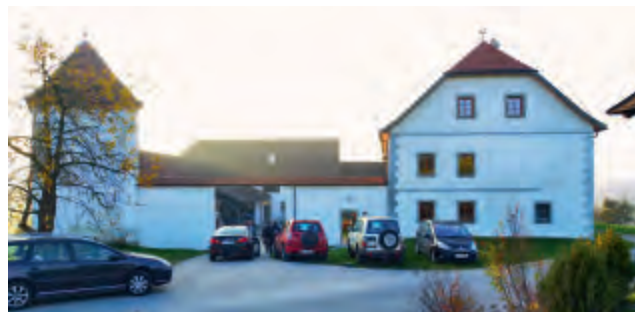
Abb. 23: Trotz Umbauten ist das Gepräge der Schlossanlage noch gut erkennbar. Das Gebäude reicht im Ursprung bis ins Mittelalter zurück und steht unter Denkmalschutz. Foto: Erhard Fritsch, Landesverein für Höhlenkunde in OÖ
