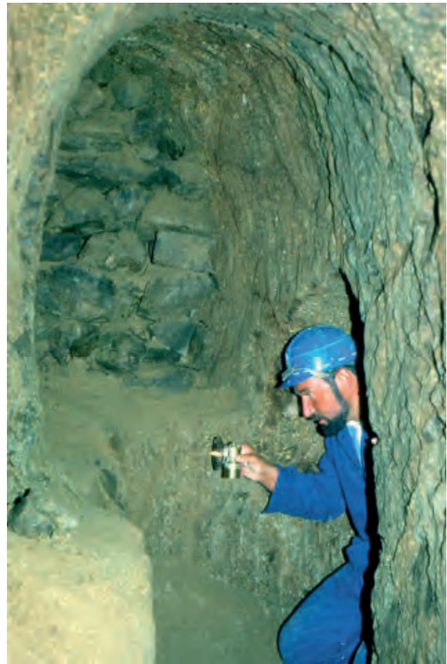
Abb. 19: Die Errichtung eines Erdstalls über einen Bau(hilfs)schacht brachte viele Vorteile mit sich, u.a. verkürzte sich die Bauzeit, weil mehrere Mineure gleichzeitig am Vortrieb der Gänge arbeiten konnten. Foto: Josef Weichenberger
