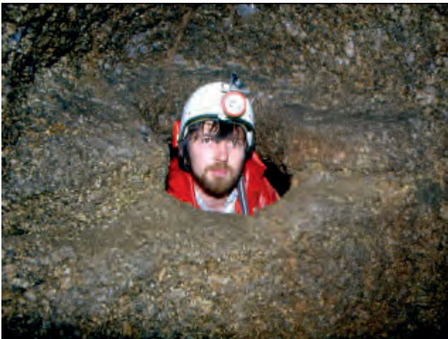
Abb. 3: Schlupf sind das typischste Bauelement eines Erdstalls. Foto: Erhard Fritsch
