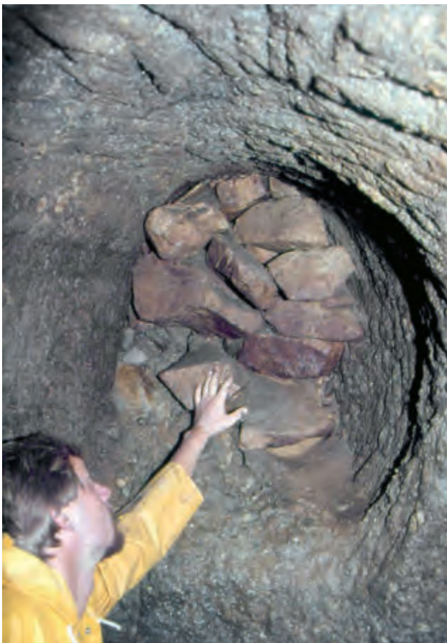
Abb. 17: Trockenmauern, also ohne Mörtel zusammengefügte Steine, weisen stets auf einen Bauschacht hin.
